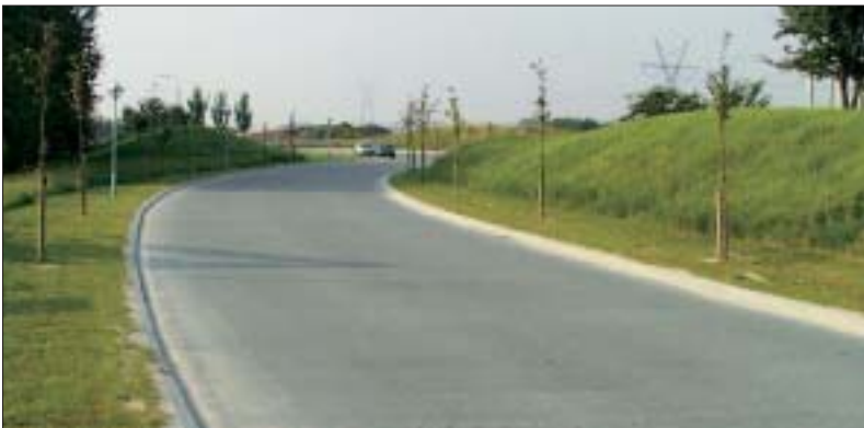
Figur 2.1. Betonsten og fliser er også meget velegnede til almindelige veje. Her en nyanlagt adgangsvej til en industrivirksomhed.
