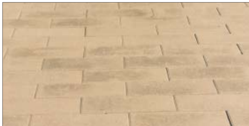
Figur 4.10. Disse skæmmende brunlige plamager er opstået fordi kalkudfældninger har bundet finstof fra fugegrus der har ligget på belægningen. Dette kunne være undgået ved at feje belægningen ren efter fugningen.
