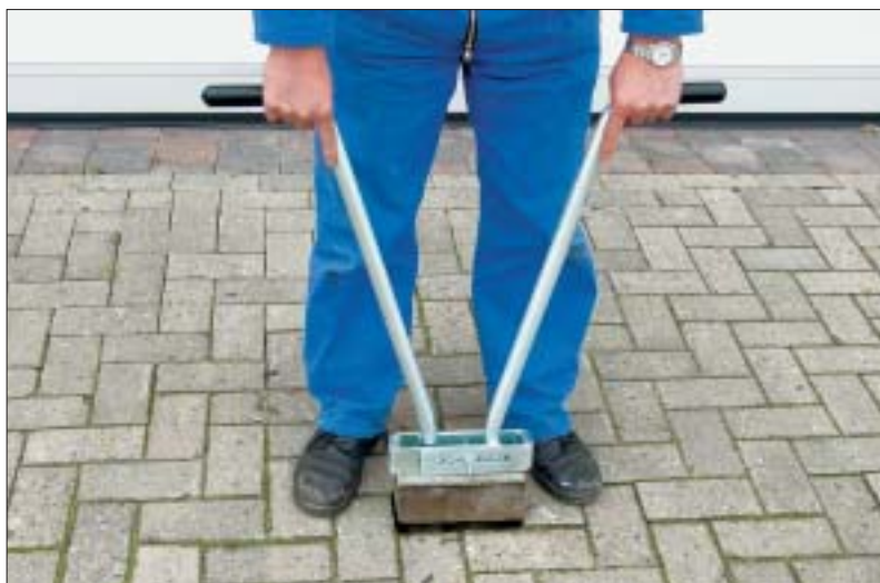
Figur 4.17. Der findes forskelligt specialværktøj til betonstensarbejde, bl.a. til optagning af sten.
