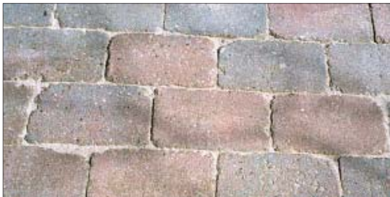
Figur 2.12. Et eksempel på efterbehandlede sten er betonsten med slæde kanter. Disse får et mere rustikt udseende.
