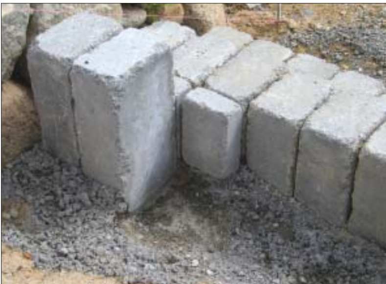
Figur 3.51. Sætning af trappe i jordfugtig beton.
