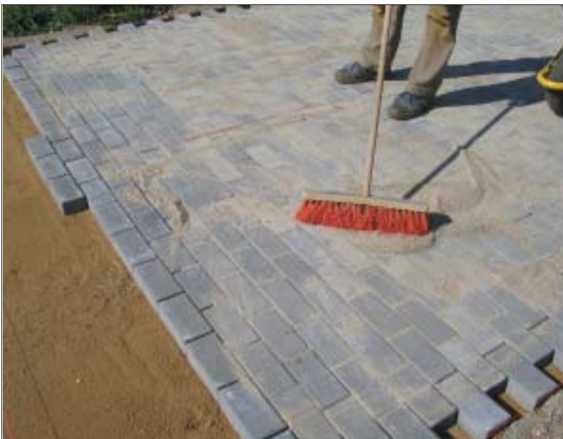
Figur 3.35. Fugegrus fejes i fugerne inden første vibrering.
