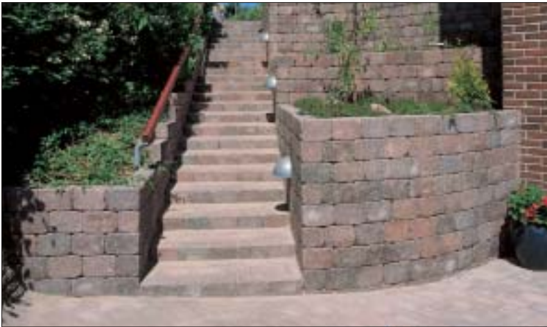
Figur 2.21. Der findes flere forskellige typer støttemursblokke, her er benyttet en enkel blok med slåede kanter, der passer til belægningen. Til trappen er der også benyttet blokke og betonsten.
