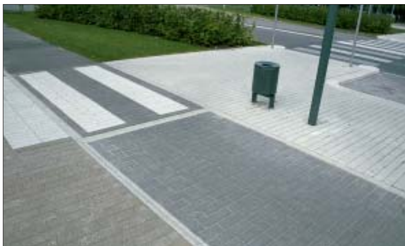
Figur 2.2. Adskillelse af biler, cyklister og gående kan ske smukt og effektivt med betonsten i forskellige farver og varierende overflader. (Allerød).
