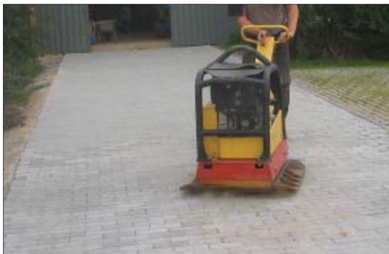
Figur 3.37. Det benyttes en stor pladevibrator på min. 180 kg til vibrering.
