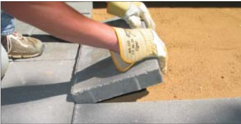
Figur 3.41. Fliserne lader man som betonsten, skride skråt ned for at opnå den korrekte fugebredde på 2-5 mm.
