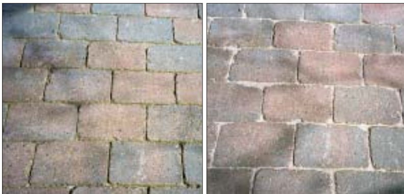
Figur 4.15. Belægninger efterfyldes med nyt fugegrus, straks der mangler noget. Det kan typisk være nødvendigt om foråret.
