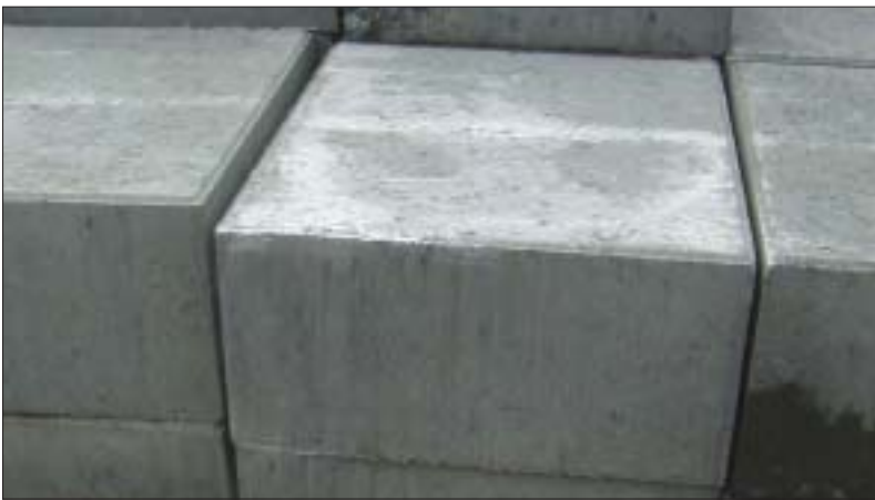
Figur 4.9. Kalkudfældninger opstår også ved oplagring på paller. Disse kalkudfældninger er almindelige og forsvinder i løbet af 1 - 2 år.
