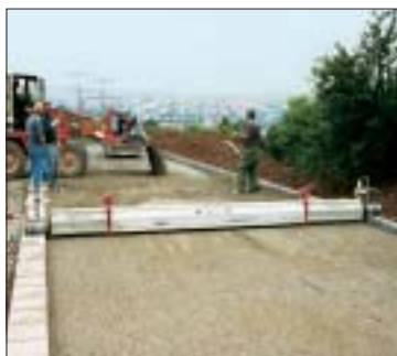
Figur 3.24. Udstyr til afretning. Afretningen kan også blot foretages med et lige bræt og ledeskinner i form af jernrør der lægges i afretningslaget.
