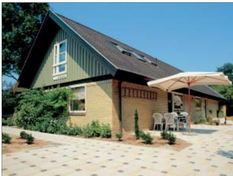
Figur 2.15. De sydlandsk-inspirerede belægningssystemer er noget forholdvis nyt i Danmark, og adskiller sig markant fra de betonsten og fliser der normalt benyttes.
