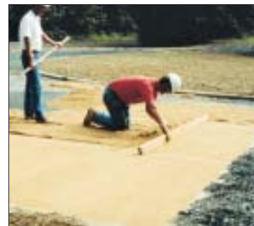
Figur 3.24. Udstyr til afretning. Afretningen kan også blot foretages med et lige bræt og ledeskinner i form af jernrør der lægges i afretningslaget.
