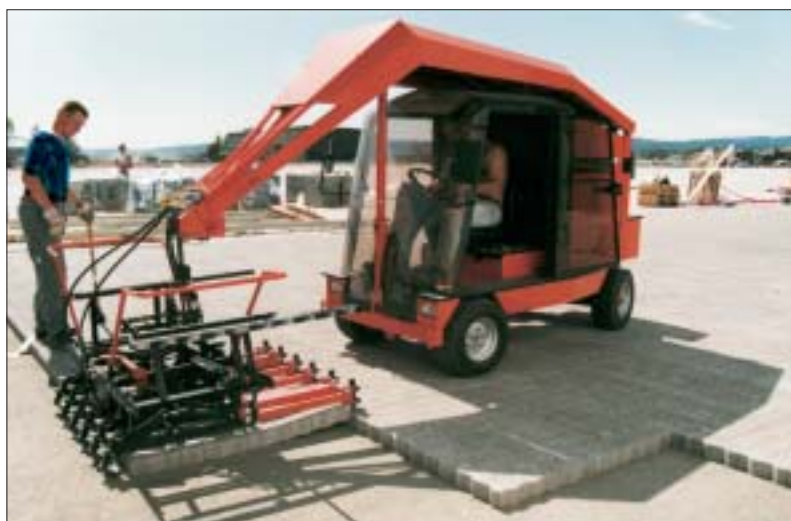
Figur 3.28. Maskinnedlægning af betonsten - hurtigt og effektivt.
