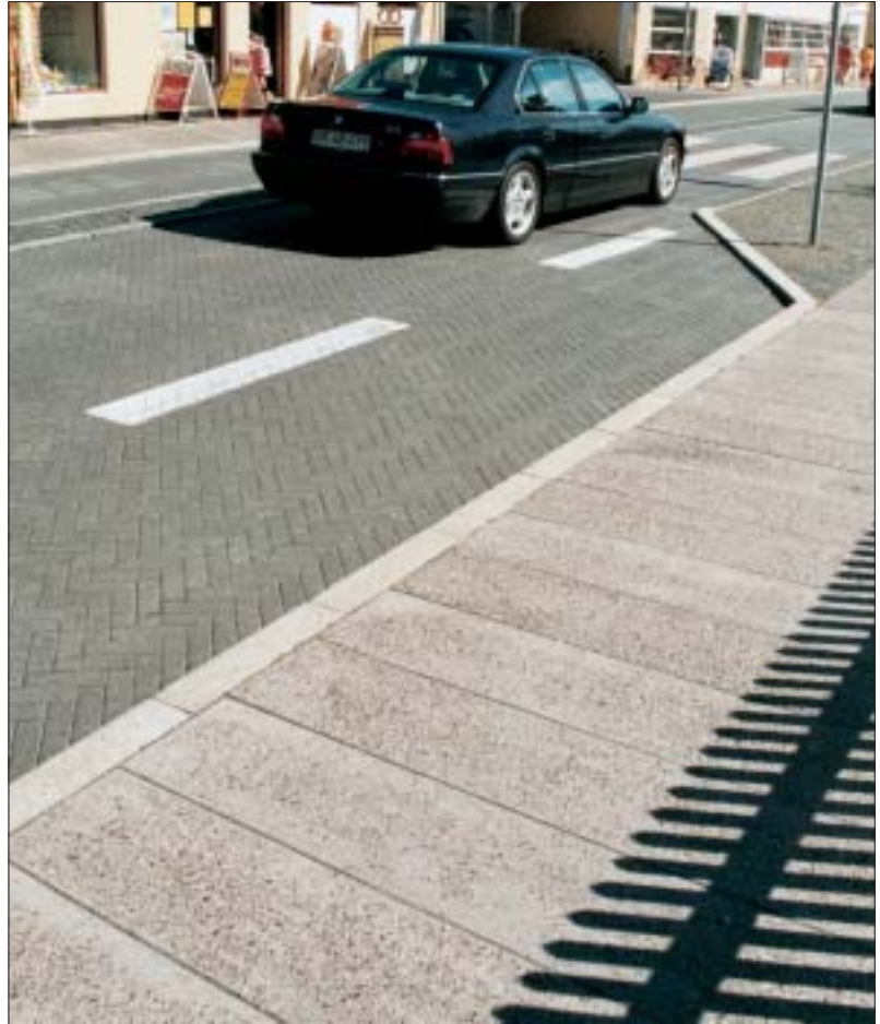
Figur 1.2. I bymidter benyttes ofte både standardsten og specialprodukter. Her er benyttet en standard 7x21 cm sten i kørebanen og store aflange specialfliser på fortovet. (Skagen).
