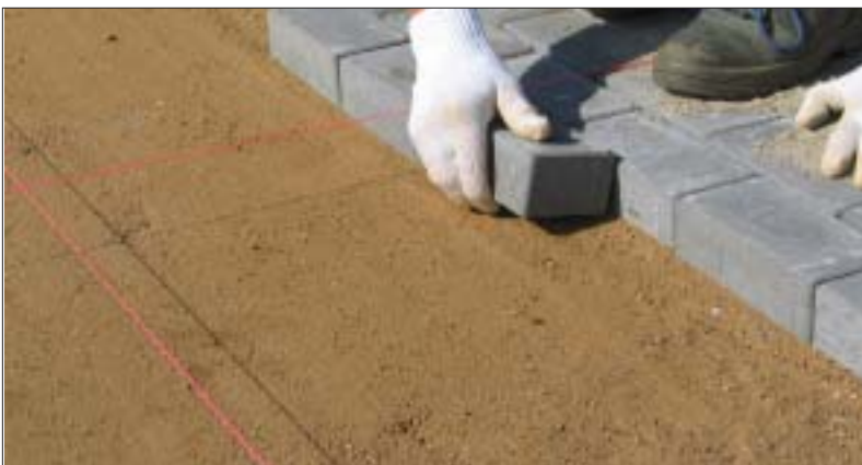
Figur 3.27. Udspænding af snore gør det let at opretholde flugterne.
