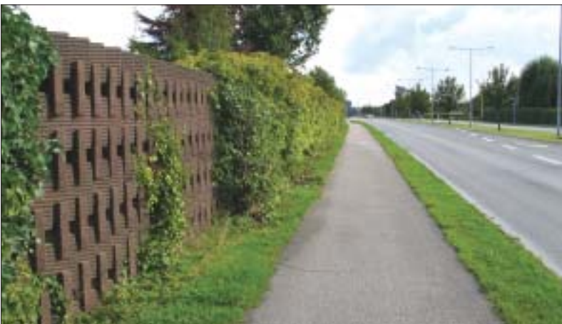
Figur 3.59. Støjmur. Muren er lavet åben for at kunne beplante den og for at reducere den støj der reflekteres.
