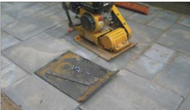
Figur 3.42. Kunststofsålen kan fremstilles af PEHD-plade.
