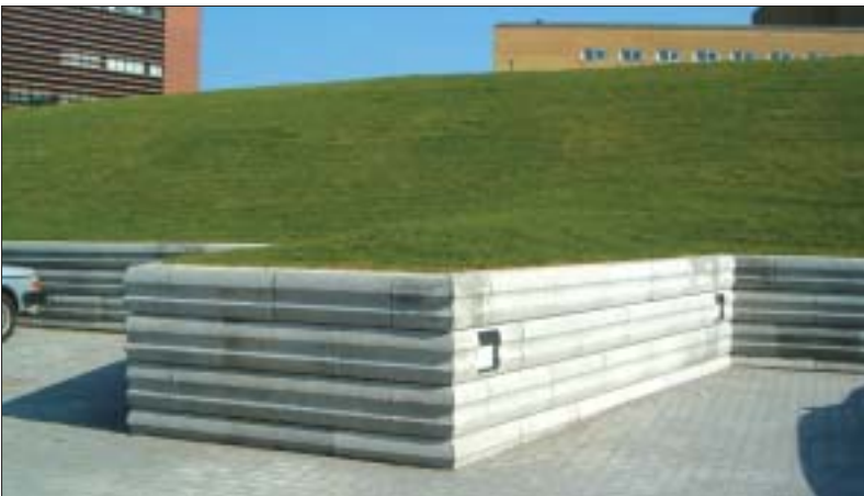
Figur 3.58. Støttemur. Det er vigtigt ved dimensioneringen, at tage højde for belastningen oven for muren, f.eks. som her jordvolden.
